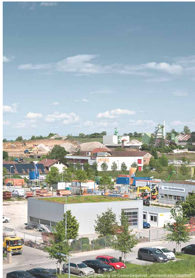
Dachbegrünung im Gewerbegebiet „Hohenacker/Obsthof“
